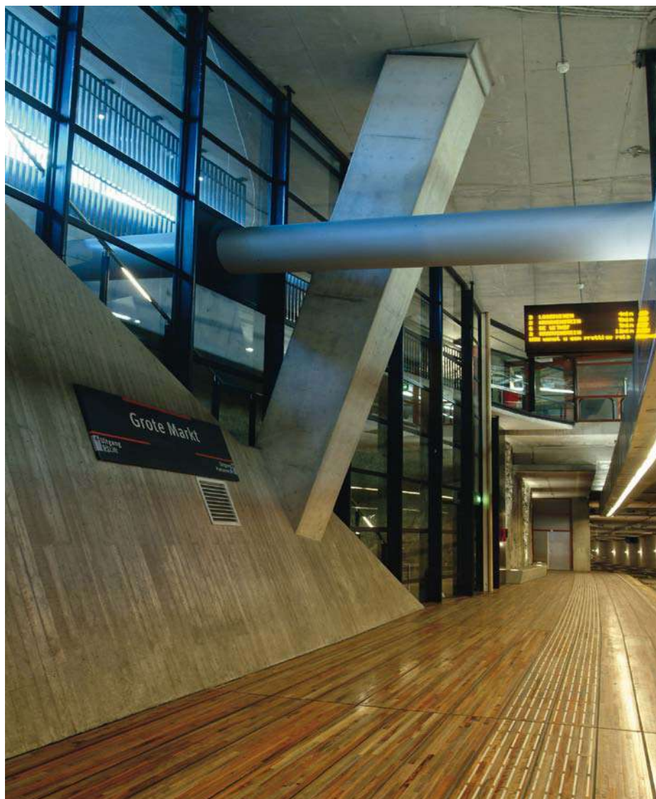
Tramtunnel Den Haag
